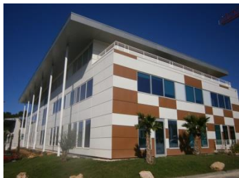
Bâtiment D Livré en 10/2011 Surface de 1 779 m 2 Occupants : 7
