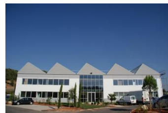
Le Shed Livré en 10/2009 Surface de 1 855 m 2 Occupants : 2
