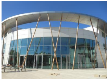
Bâtiment A Livré en 07/2013 Surface de 1 405 m 2 Occupants : 5
