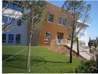
Bâtiment E Livré en 07/2012 Surface de 2 773 m 2 Occupants : 6
