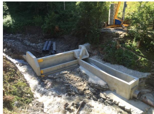
Travaux de génie civil de la prise d'eau de Samoëns
