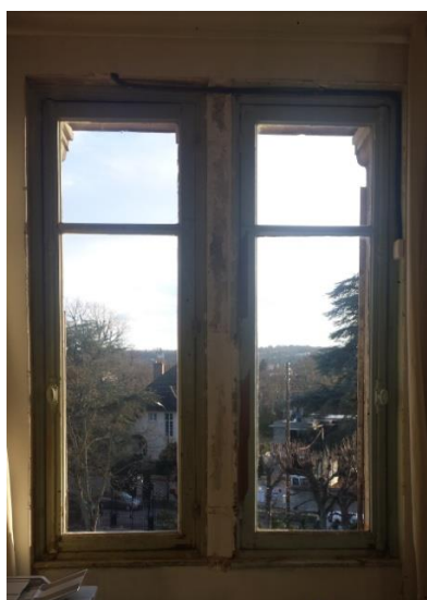
Menuiseries extérieures simple vitrage
