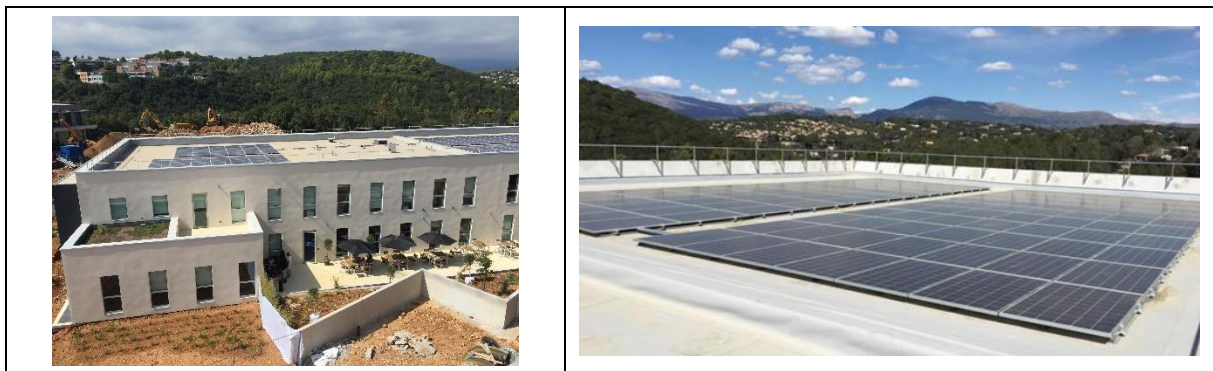
BIOT bâtiment C – 59.8 kWc
