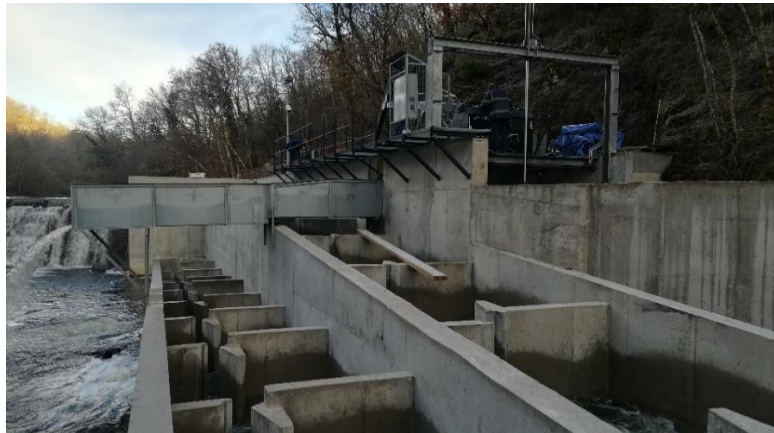
Photographie d'une passe à poisson en rive droite
