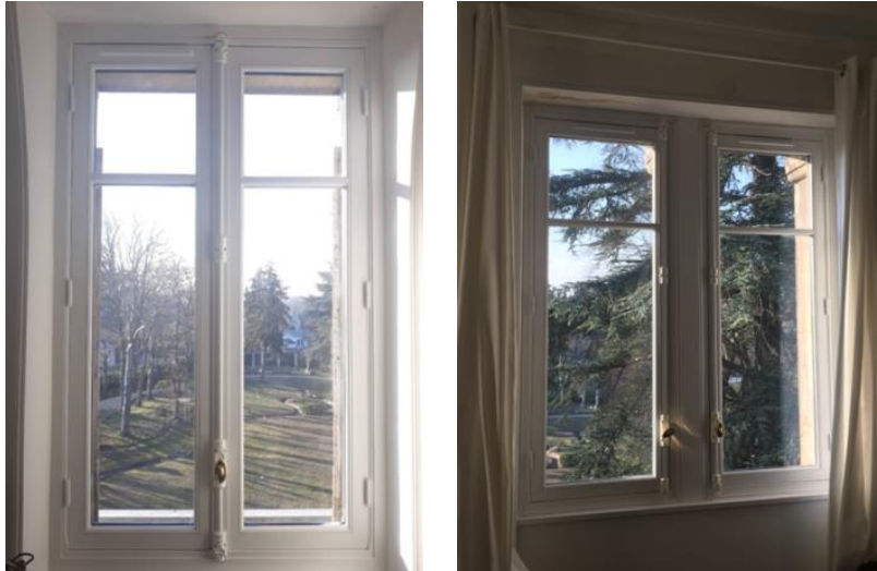
Photographies des nouvelles fenêtres double vitrage au second étage
