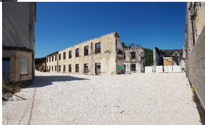
Photographies de la centrale de Colombier
