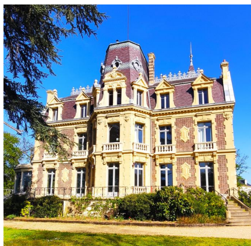
Photographie de la toiture post-travaux
