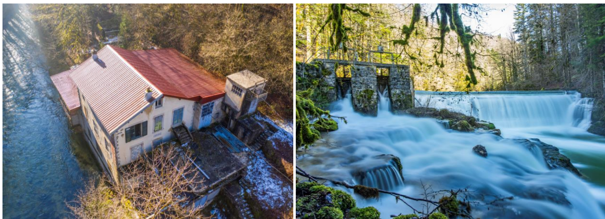
Photographies de la centrale de Tancua
