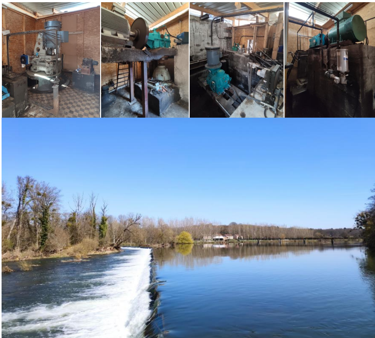
Photographies de la centrale de Colombier (4 groupes & barrage)
