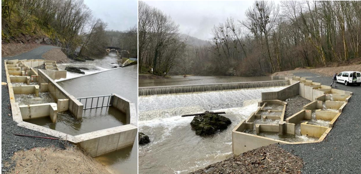
Photographies de la passe à poissons de Moulin du Pont
