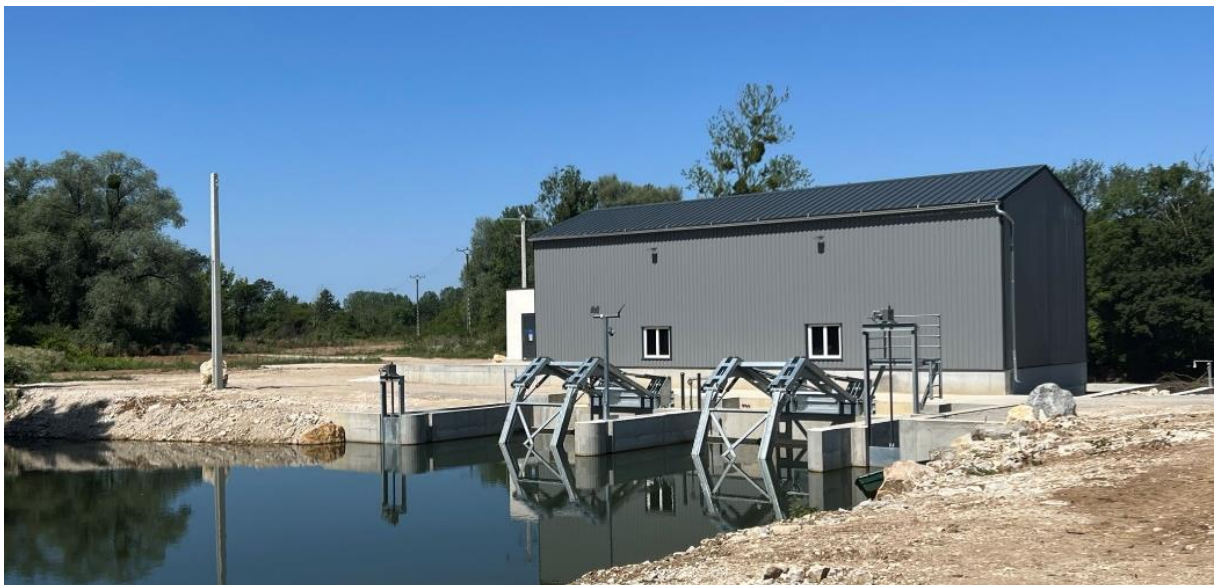
Bâtiment de la nouvelle centrale
