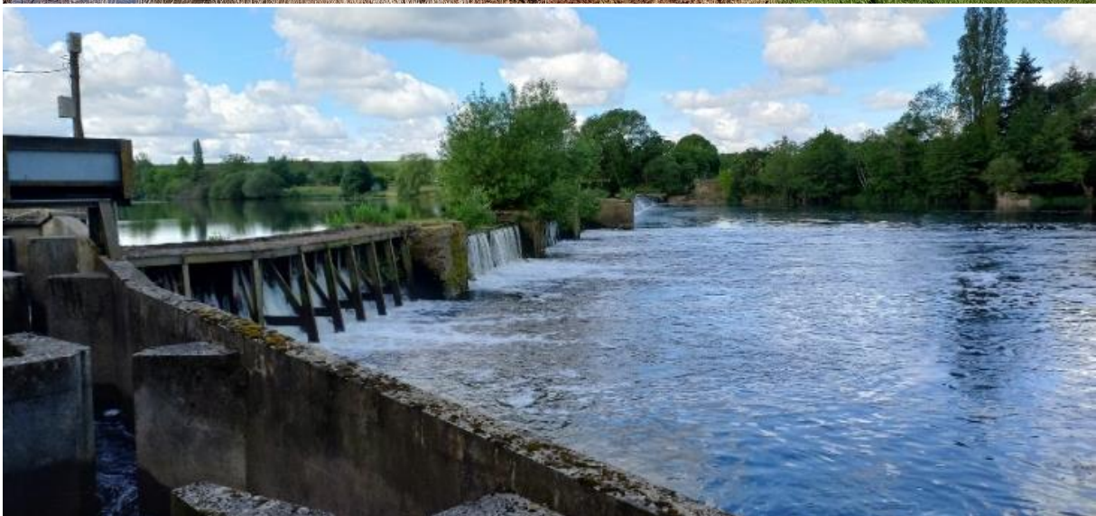
Photographies de la centrale hydroélectrique de Saint-Mars
