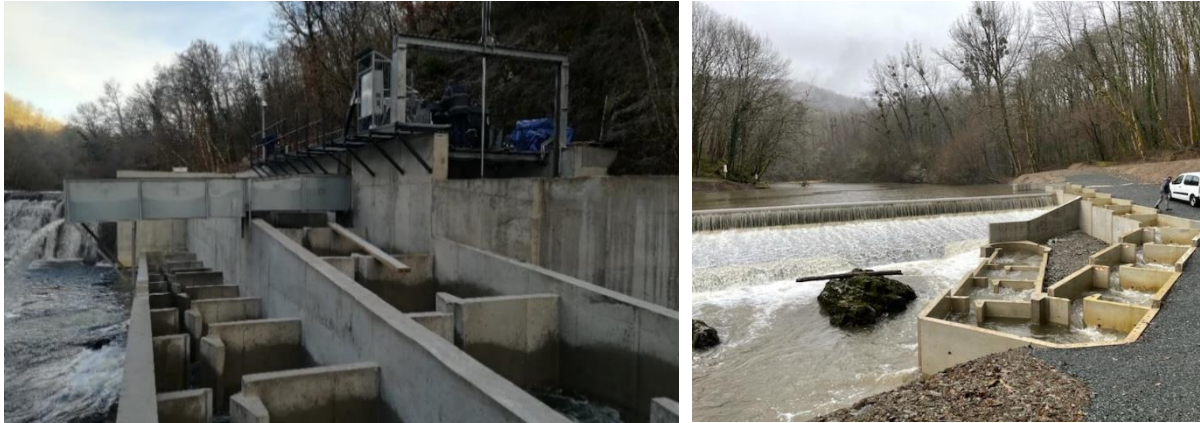
Photographie des passes à poissons des centrales de Marvit (2018) & Moulin du Pont (2020)
