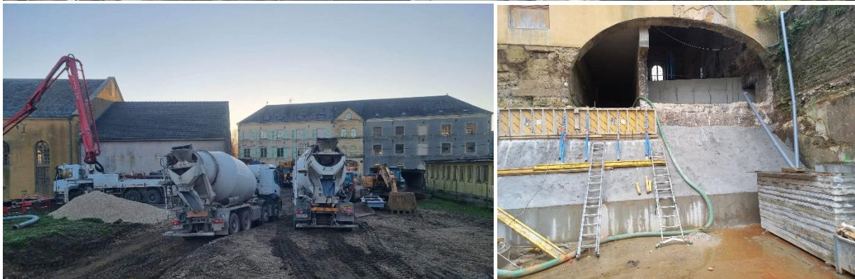
Reconstruction de la chambre d'eau et canaux d'arrivée et sorti d'eau (génie civile)
