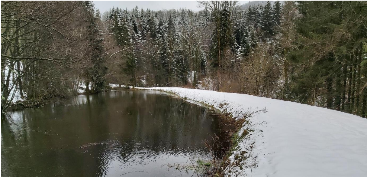
Photographies de la centrale hydroélectrique du Ménil
