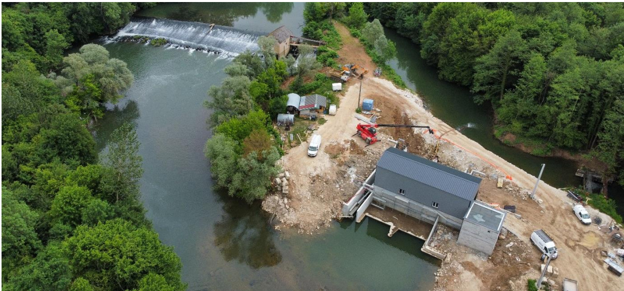
Construction de la nouvelle centrale en cours (travaux prise d'eau)
