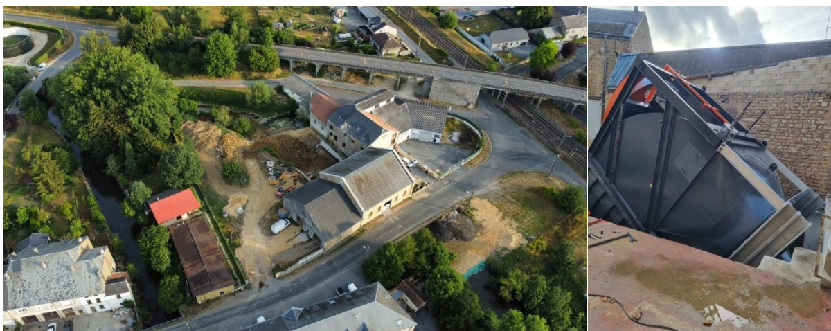
Reconstruction de la chambre d'eau et canaux d'arrivée et sorti d'eau (génie civile)
