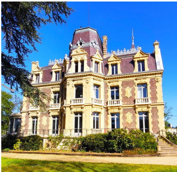
Photographie de la toiture post-travaux
